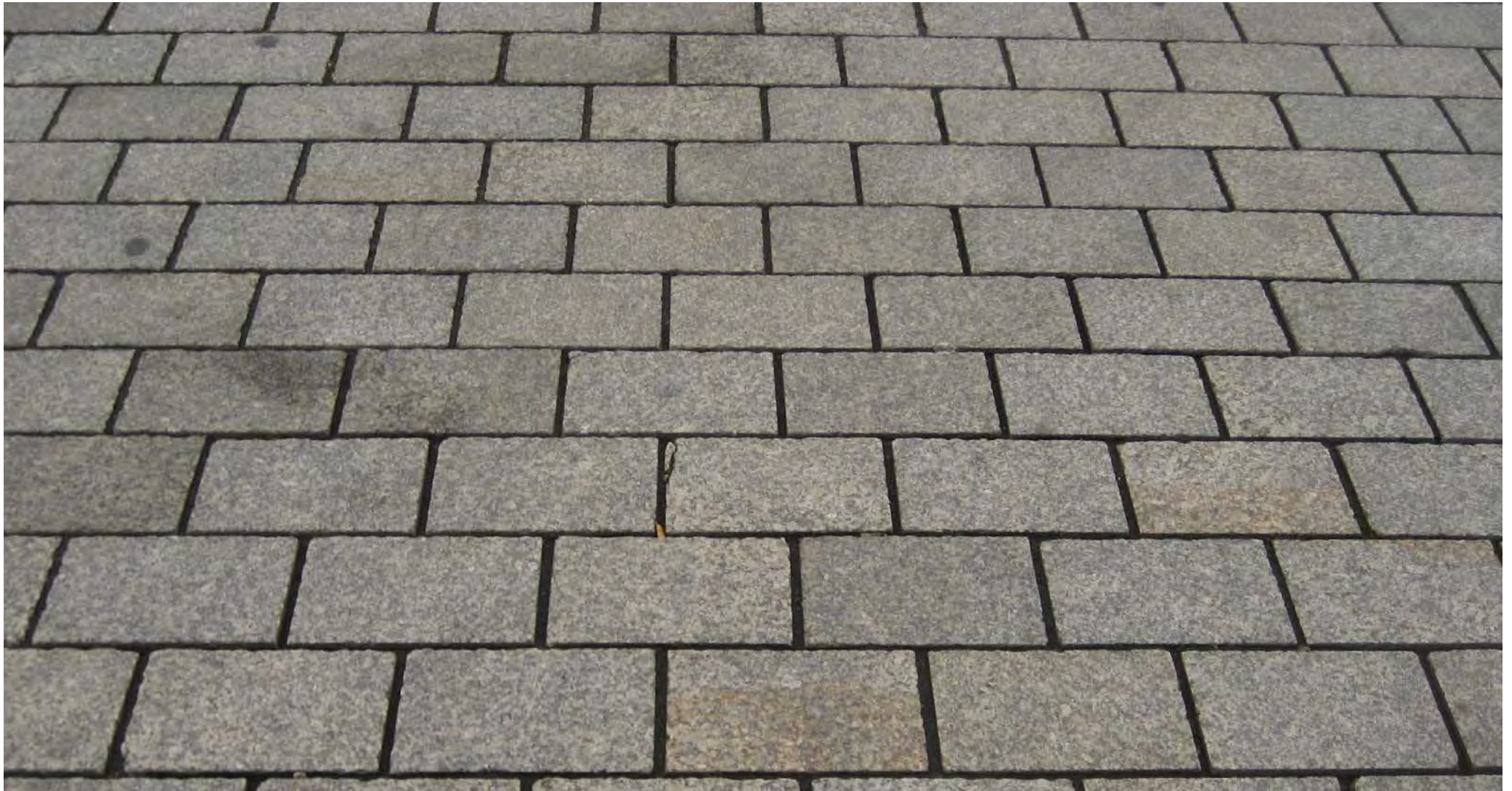
Granit - Großpflaster, gesägt, Halbverband
