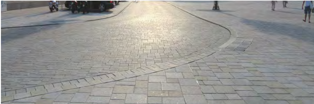
Variante 1- Fahrspur Bk 10,0, Großsteinpflaster (gebundene Bauweise - Sonderbauweise):
